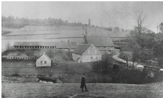
Gottlieb Lambach vor seiner Firma, direkt an der Wupper gelegen (die hier noch Wipper heißt), etwa um 1900. Zu dieser Zeit betrieb er außer der Maschinenfabrik auch eine Ziegerei. Ein Großteil der Gebäude steht auch heute noch fast unverändert.
